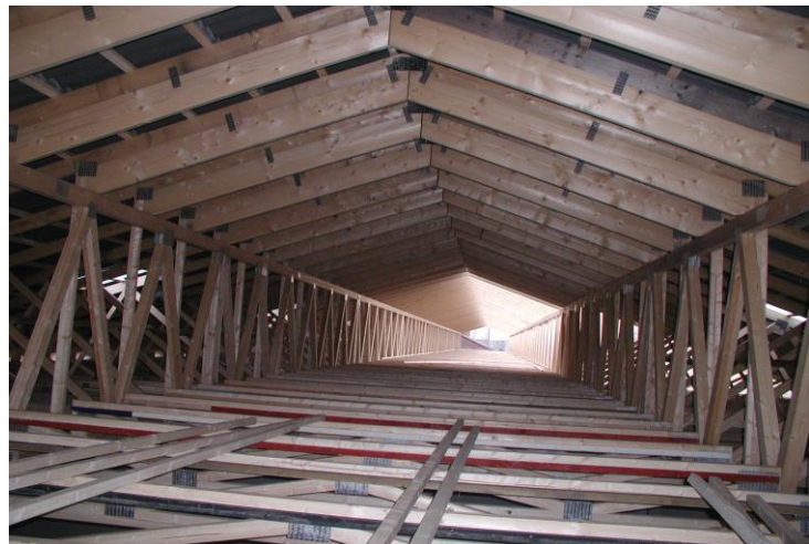
Figur 7 Opbygning af central luftkanal
